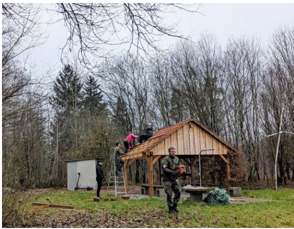
△ Abb. 1: Abbau der Grillhütte durch das Stammpersonal ZGeoBw III 3 Lehre/Ausbildung (Quelle: Bundeswehr)
