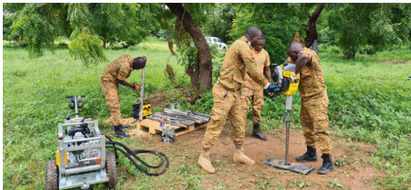
△ Abb. 4: Geotechnische Erkundung mit Ausbildungscharakter für ausländische PiKr (SRT/MTT) im Auftrag der DEUBerGrpBw Burkina Faso (Quelle: Bundeswehr/Hermel)
