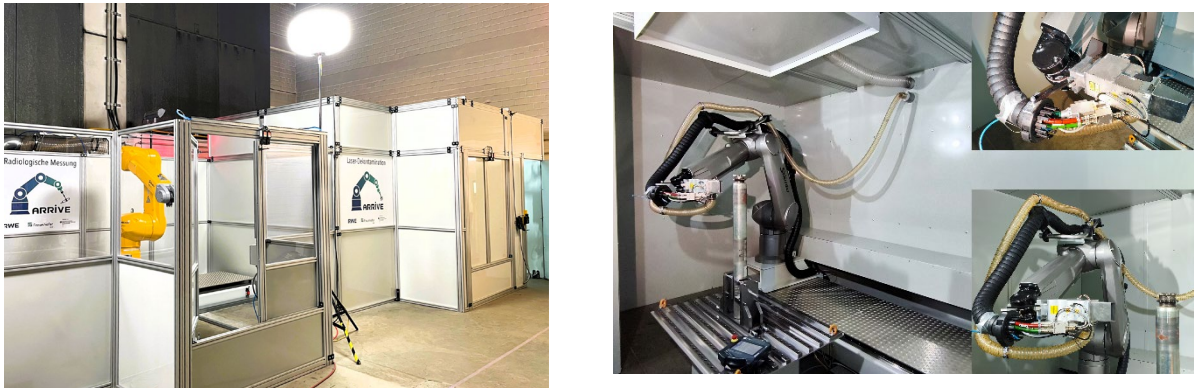
Abbildung 3: Roboterzellen im finalen Aufbau für den Probebetrieb am Standort der Rückbauanlage
