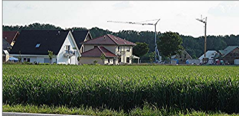
Neubaugebiet am Rand eines der Ortskerne (Foto: A. Todt)
