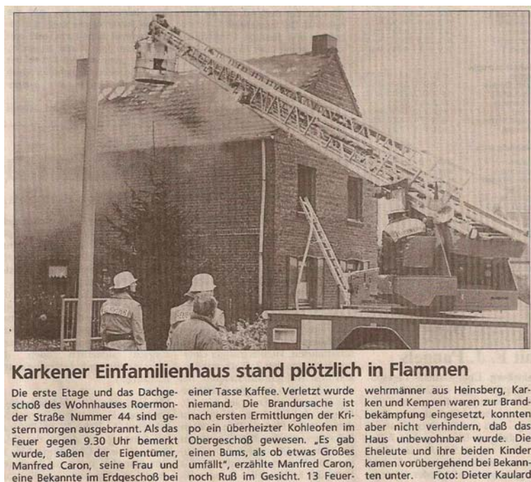
Wohnhausbrand auf der Roermonder Straße am 2. Dezember 1994
