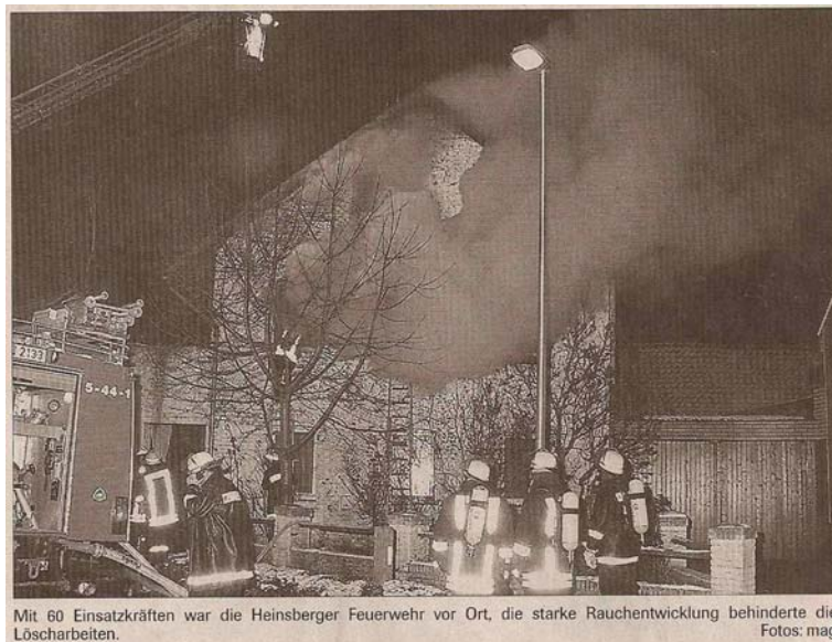
Wohnhausbrand Karkener Straße am 05.01.2002
