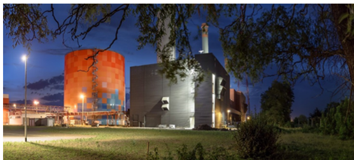
Abb. 29: Oberirdischer Wärmespeicher für Energiepark Dieselstraße, Stadtwerke Halle (SWH) (Bild: Agentur Kappa)
