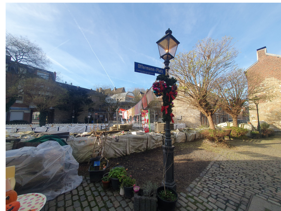
Abbildung 01: Provisorischer Hochwasserschutz am Offermann-Platz
