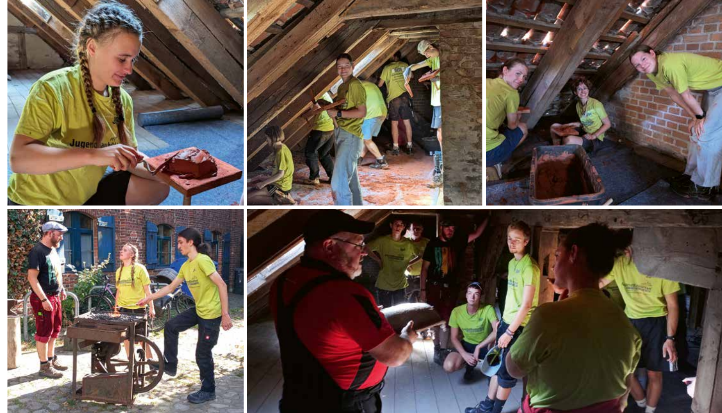
von oben links: sorgsamer Umgang mit dem Arbeitsmaterial, Dachsanierung im historischen Speicher, unsere mobile Schmiede im Einsatz, Fugenverstrich im historischen Speicher
