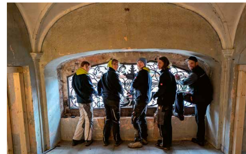
Ansicht Halbes Schloss, Einbau Schmuckgitter
