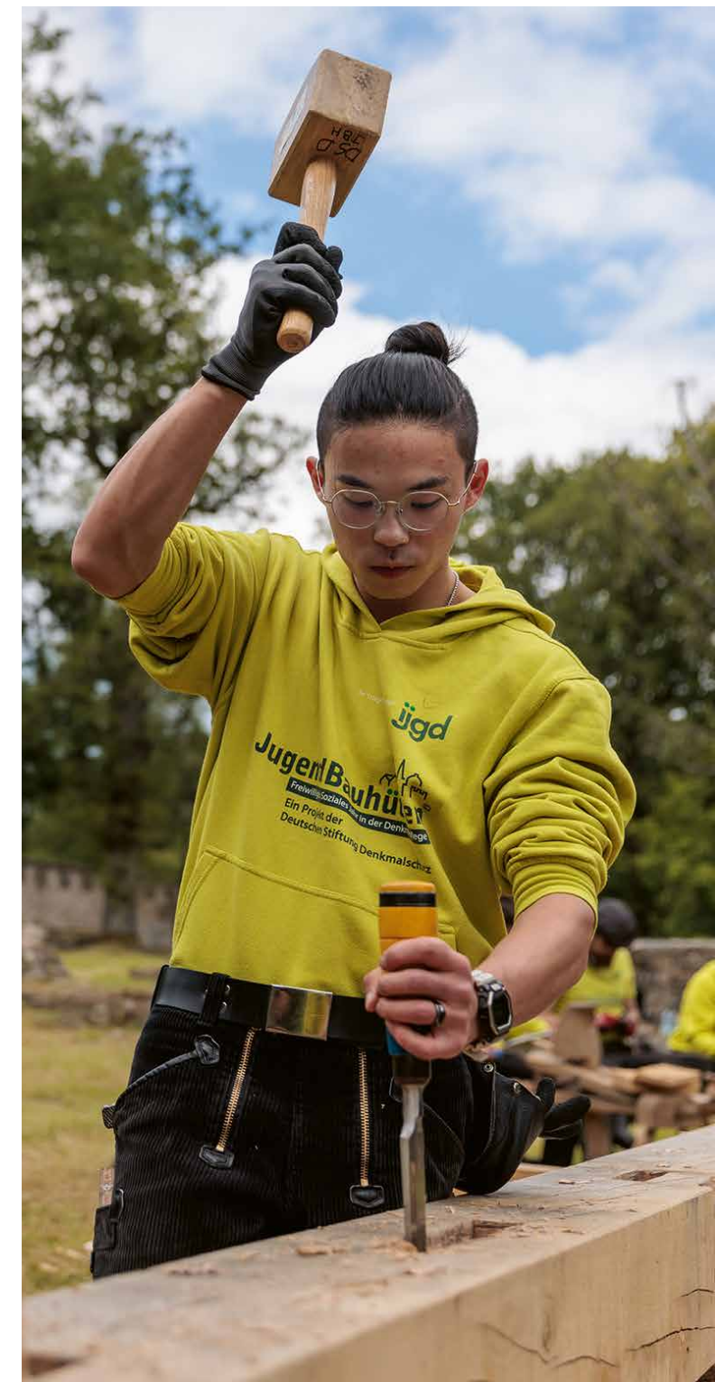
Jugendbauhütte Hessen-Marburg: Zimmerei Saalburg
