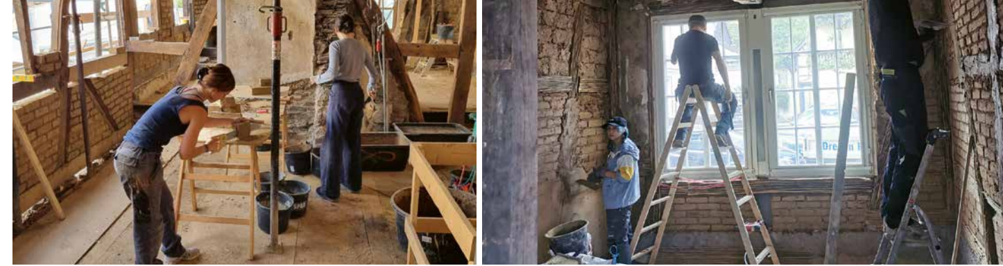
Fachwerkarbeiten des Mobilen Teams Fluthilfe
