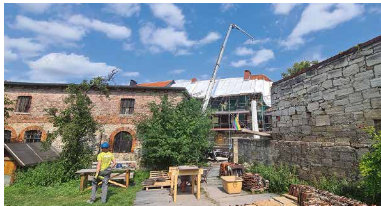
Ausbringen einer Sandschüttung zum Schutz des Innenhofes, Scheepers Haus, Bergen, Reinigen und Sortieren der Dachziegel
