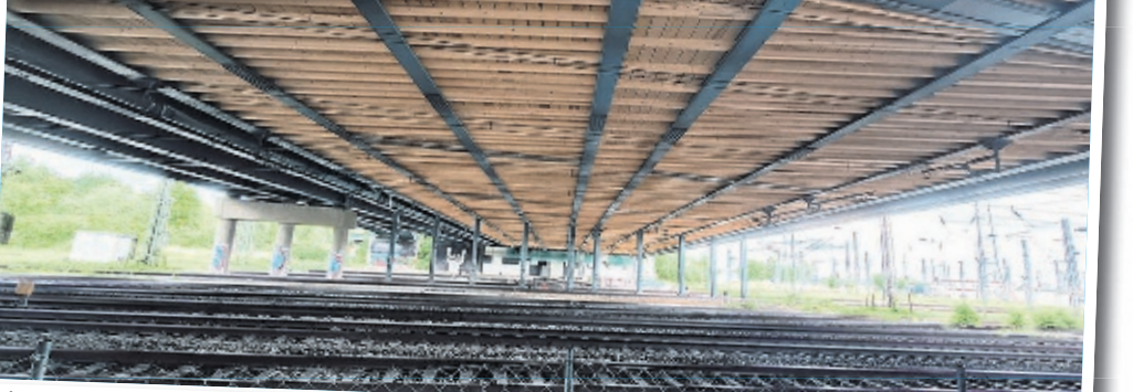
Die marode Brücke wurde bereits von unten abgesichert, jedoch reicht diese Maßnahme nicht aus, um den Verkehr normal über die Fahrbahn rollen zu lassen. Foto: Trzeciak
