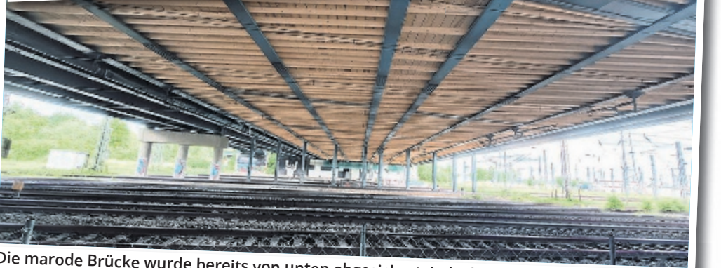
Die marode Brücke wurde bereits von unten abgesichert, jedoch reicht diese Maßnahme nicht aus, um den Verkehr normal über die Fahrbahn rollen zu lassen. Foto: Trzeciak
