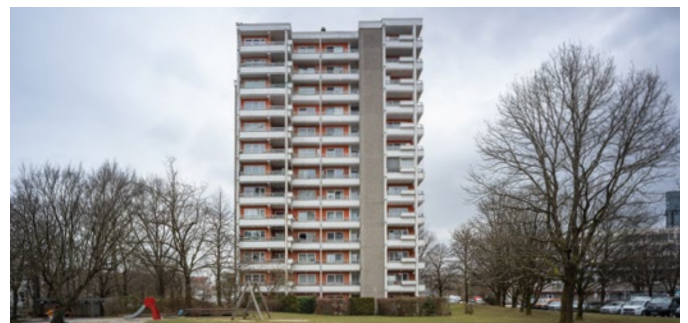
Abb. 4: BAK 3, Lindenring 4 (1971) – 13-geschossiges Punkthochhaus mit Waschbetonfassade und integrierten Balkonen; Foto: Michael Heinrich
