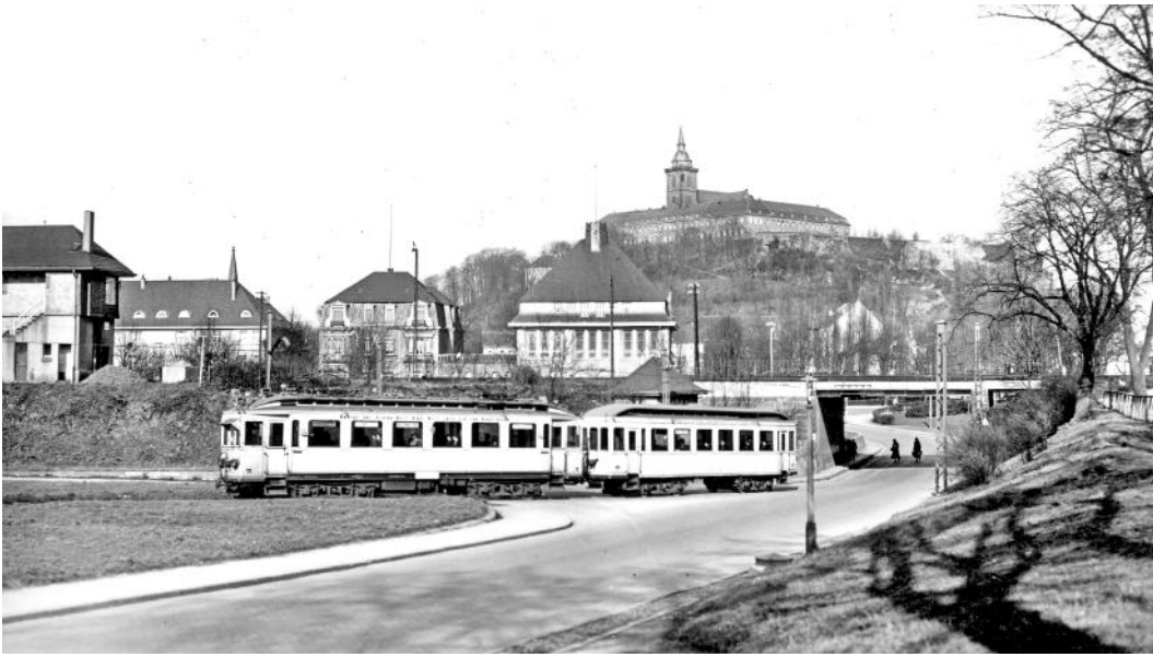
Ein SSB-Zug mit Triebwagen 15 und Beiwagen 65 hatte am 27. März 1933 die 1915 hier errichtete Eisenbahnüberführung passiert und bog in Richtung Zange ab. In der Bildmitte ist das Landratsamt zu sehen. ■ Foto: Carl Bellingrodt, Bildarchiv der Eisenbahnstiftung
