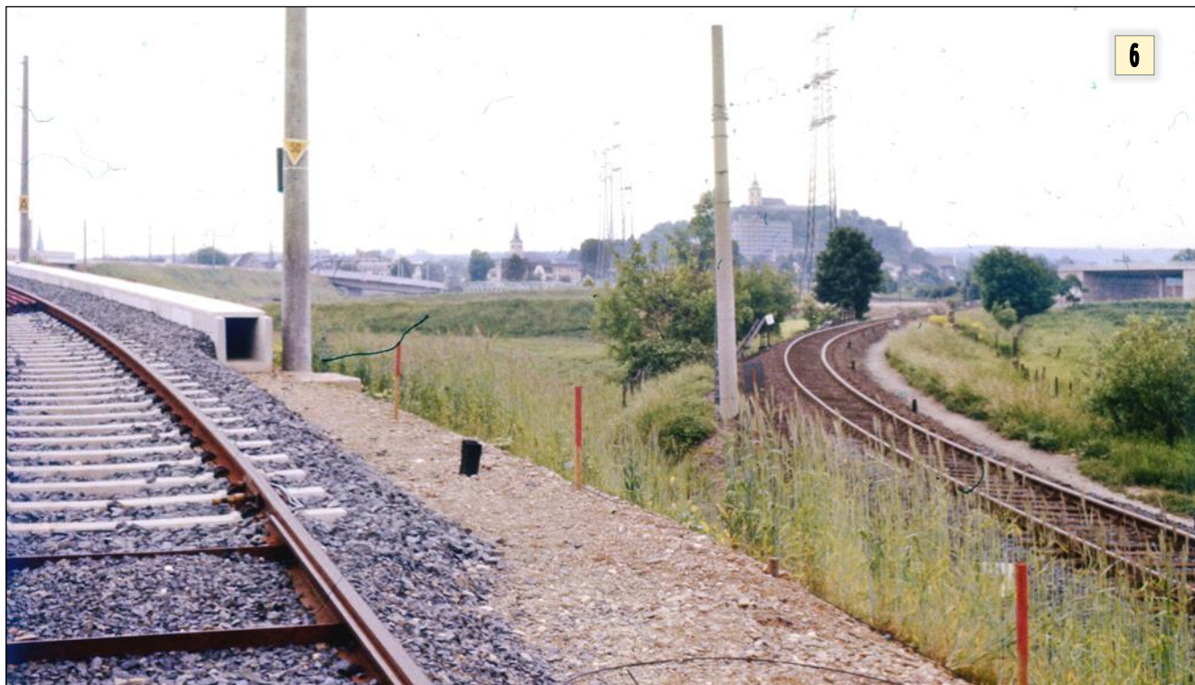
Im Aufnahmejahr, etwa 1978, wurde noch an der neuen Streckenführung (links) der SSB-Linie S gearbeitet. Rechts im Bild ist der damals aktuelle Streckenabschnitt zu sehen. Ganz rechts ist der künftige Brückenbau der B 56 über die Autobahn zu erkennen, im Hintergrund der bekannte Michelsberg. ■ Foto: Klaus Doepler, Sammlung Volkhard Stern
