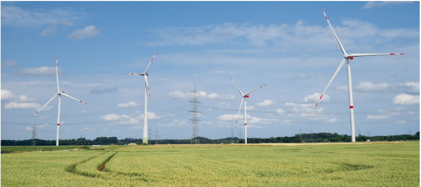
Abb. 2: Im Vordergrund drei 2025 errichtete WEA mit geringem unterem Rotordurchlauf (Standort: Düren, Rheinland, Höhenbegrenzung wegen Flughafen in der Nähe, Nabhöhe 105 m, Rotordurchmesser 149 m) und eine 2011 errichtete WEA im Hintergrund (Nabhöhe 108 m, Rotordurchmesser 82 m).
