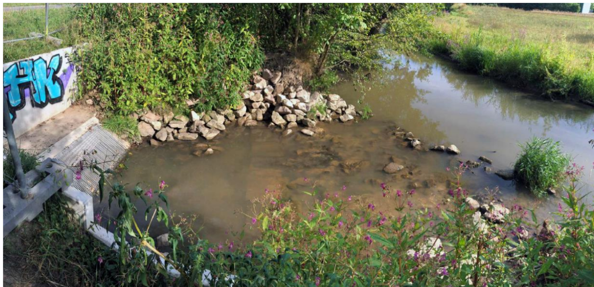
Abb. 6: Einlaufbauwerk an der Bega in Lemgo (Quelle: Seidel, C., Ostermann, L. & Clausen, J., 2025).
