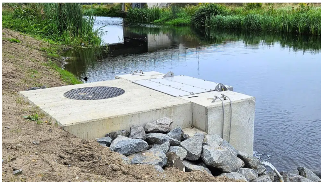
Abb. 7: Entnahmehauwerk an der Stepenitz/Wittenberge (Quelle: Windyhill Property GmbH, 2024).
