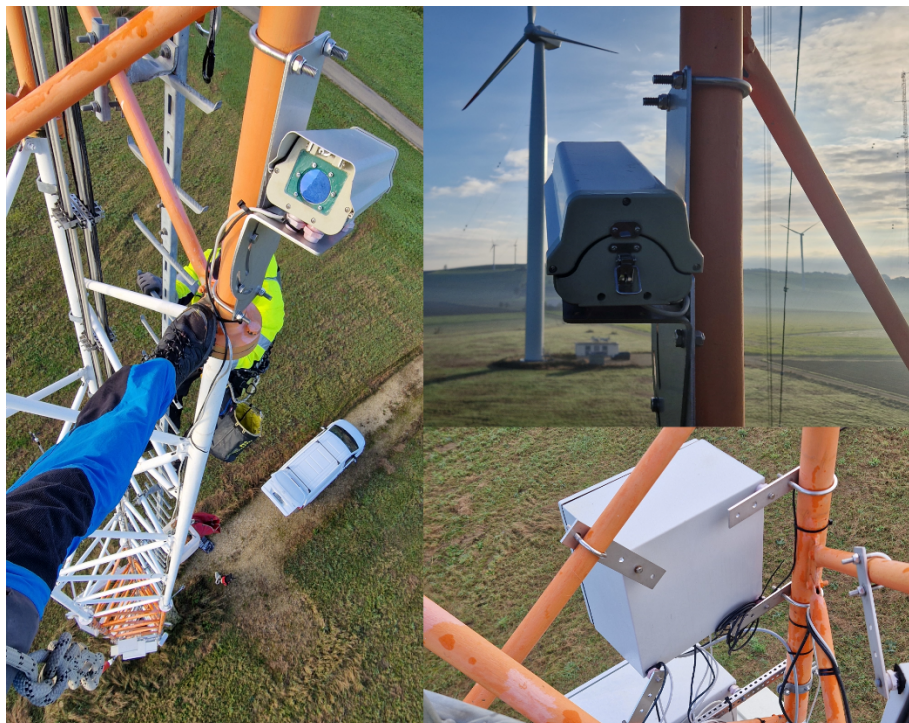
Abb. 79: Montage des Wärmebildkamera-Systems am Messmast NW; Quelle: C. Happ, UMIT Tirol.
