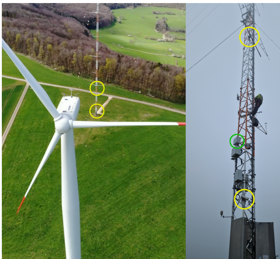
Abb. 77: Installation des Stereo-Wärmebild-Systems am nordwestlichen Messmast. Die Kameras sind durch gelbe Kreise und die Recheneinheit durch einen grünen Kreis markiert; Quelle: C. Happ, UMIT Tirol.
