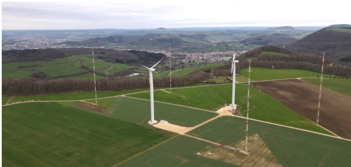
Abb. 1: Drohnenaufnahme des Windenergetestfelds WINSSENT; Quelle: ZSW
