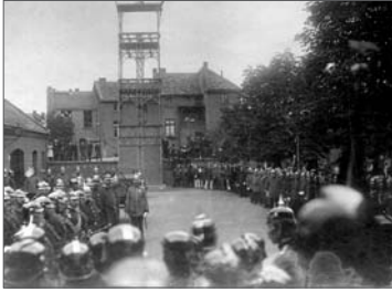
Spritzenhaus, westlicher Gebäudeteil mit Turm 1898
