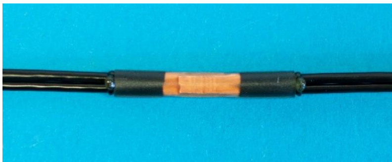
Abbildung 7-52: Kleberaustritt am Schrumpfschlauchende
