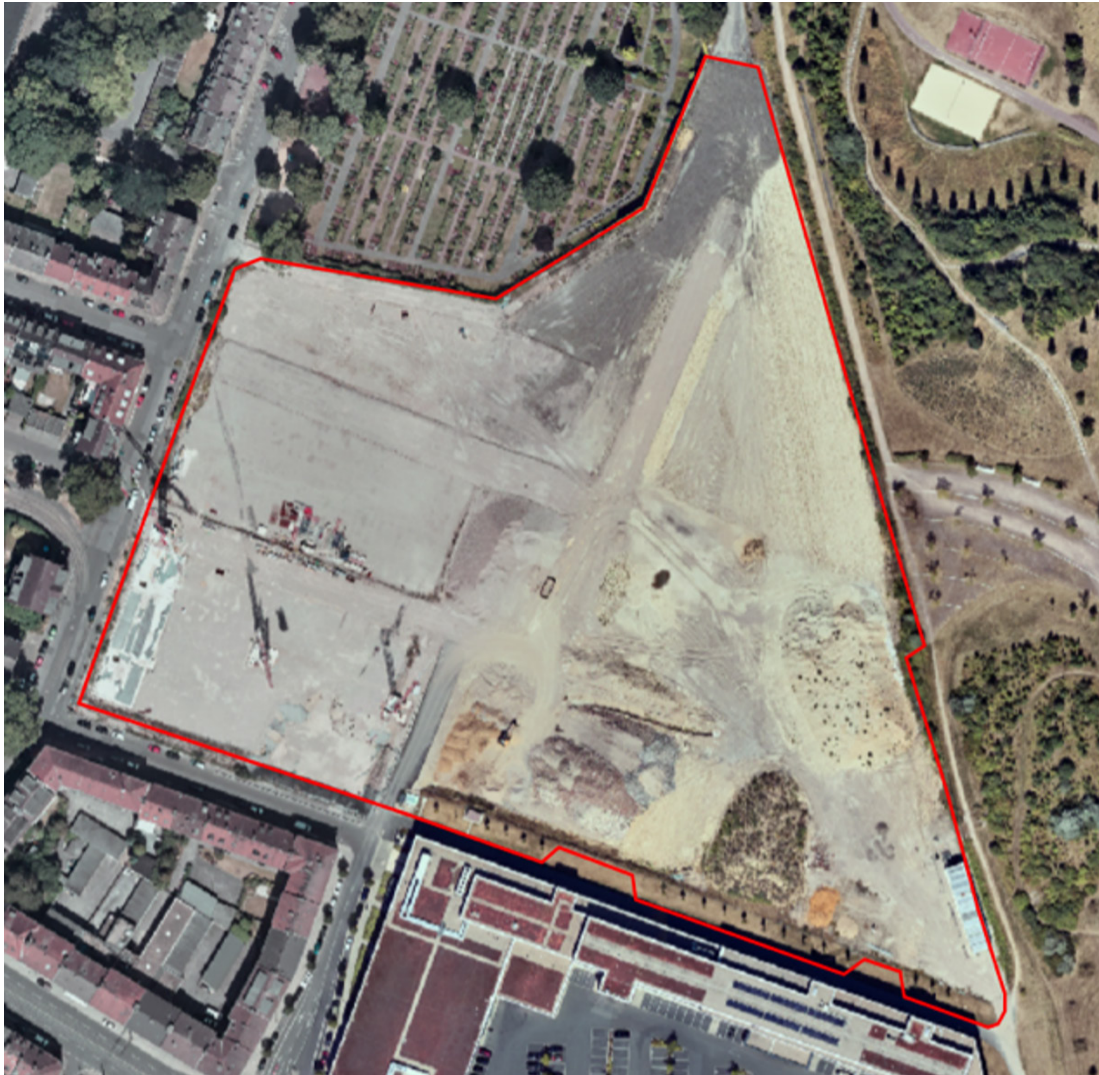
(a) DOP vom 19.07.2022. Die rot markierte Fläche ist in OSM als Brachfläche erfasst. Tatsächlich haben dort bereits Bauarbeiten begonnen, die aus dem Luftbild jedoch nicht erkenntlich sind.
