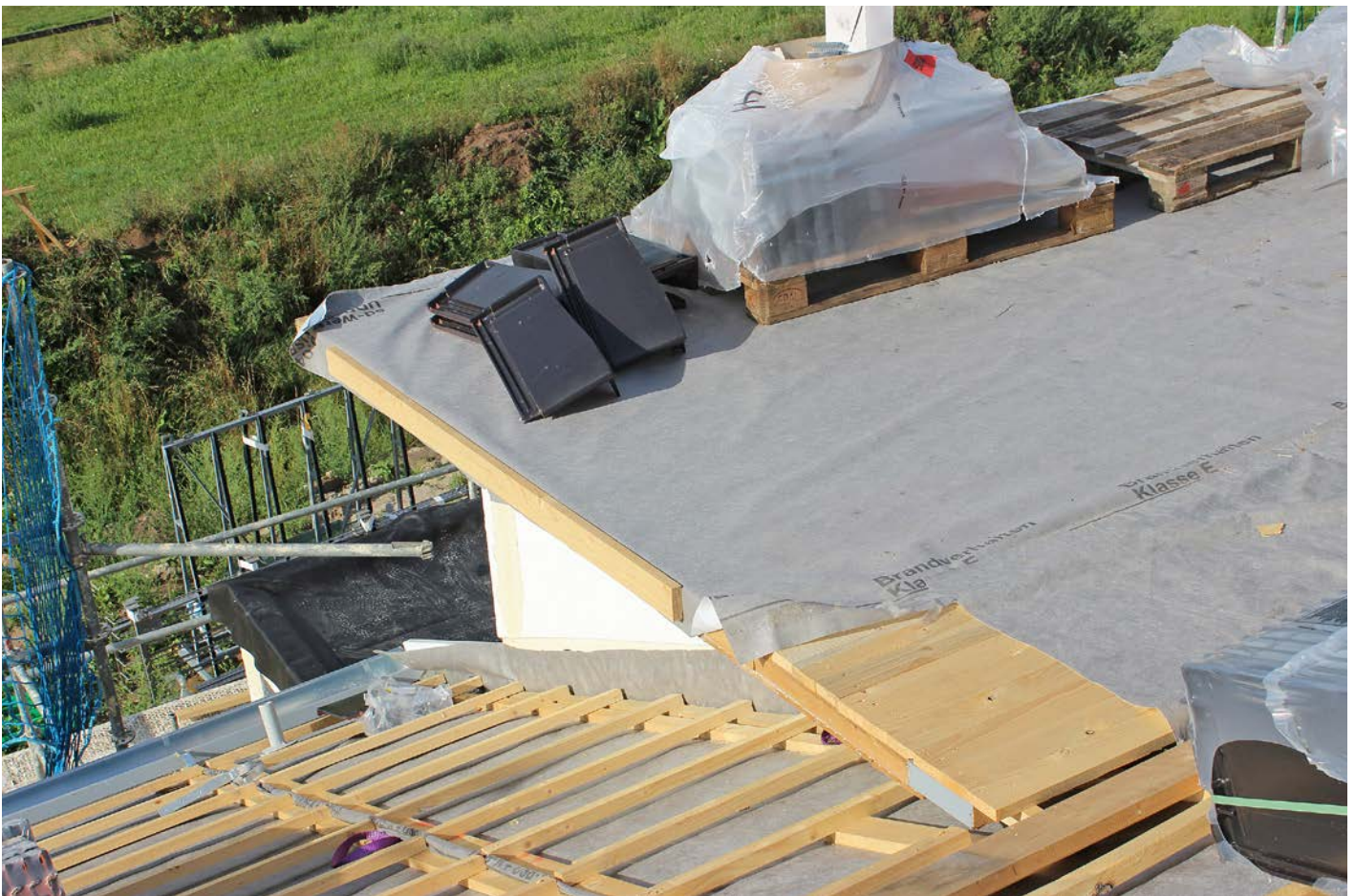
Abb. 2: Dacheindeckung mit Kunststoffanteilen: unter anderem Kunststofffolien, EPDM-Abdichtung und Kunststoffverpackungen für Tonziegel; Foto: Hochschule München
