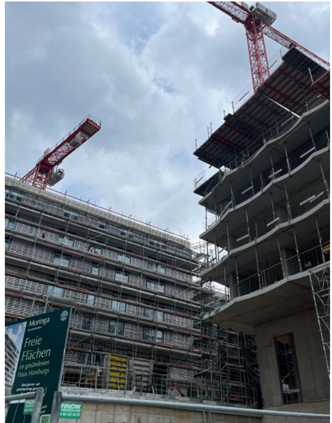
Abb. 3: Baufortschritt des Moringa-Gebäudes in der Hamburger HafenCity, mit Fokus auf die Fassade; Foto: Moringa GmbH
