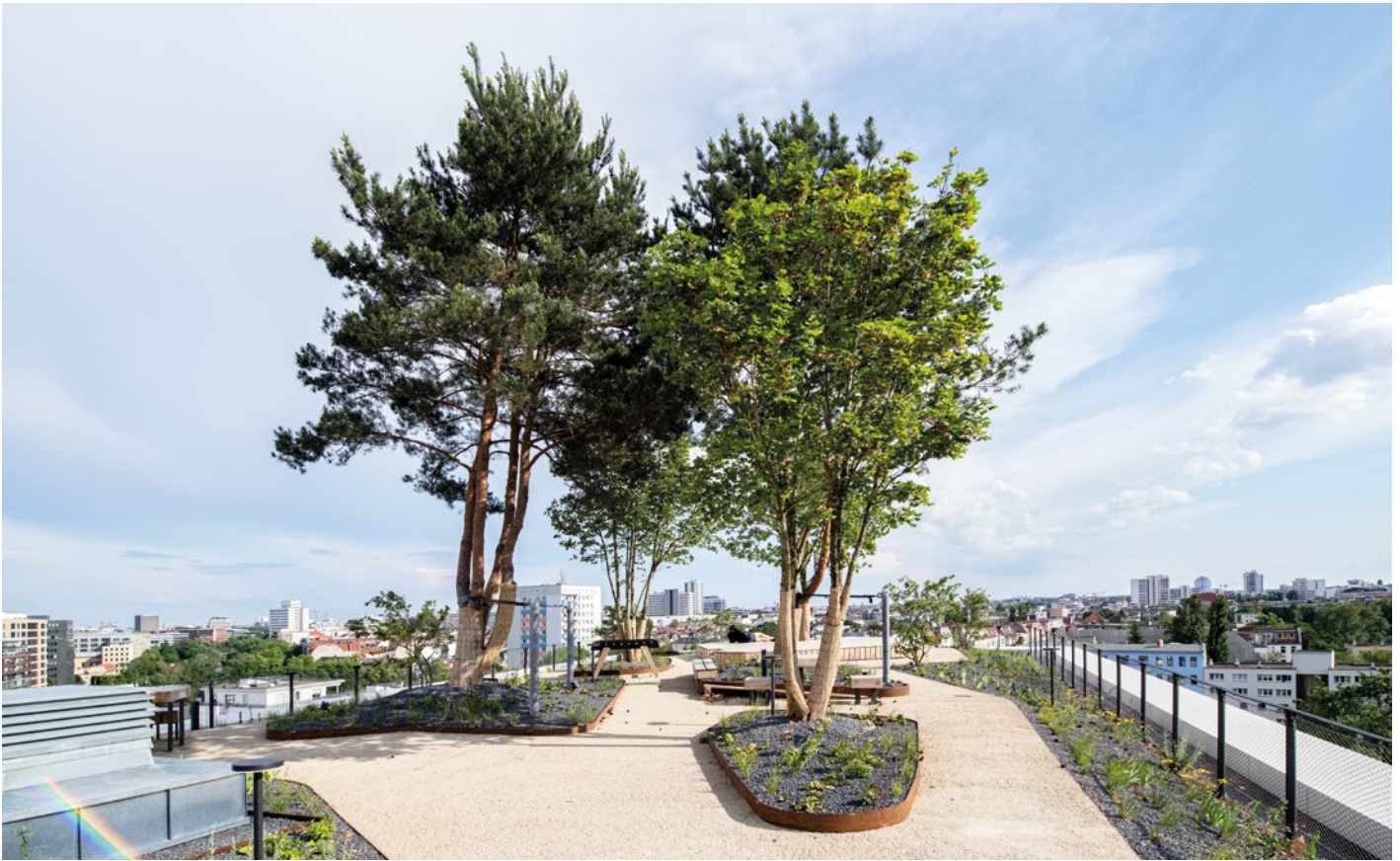
Abb. 4: Dachgarten eines 8-geschossigen Bürohauses in der Darwinstraße, Berlin; Quelle: Nicole Pfoser
