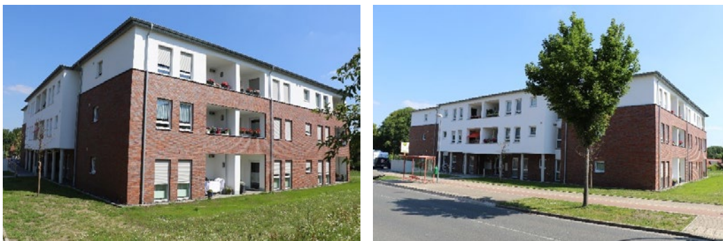
Beispiel Neubau Feldstraße in Herten; Fotos: Schettler SenioKomfort | Schettler Holding GmbH & Co. KG
