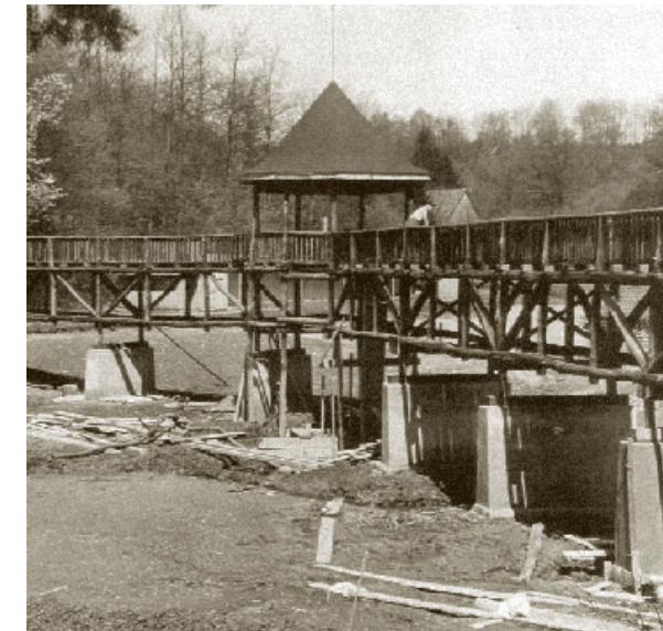
1. Sanierung der Brücke, 1950
