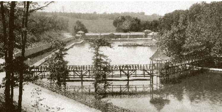
Blick über die Anlage, 1927
