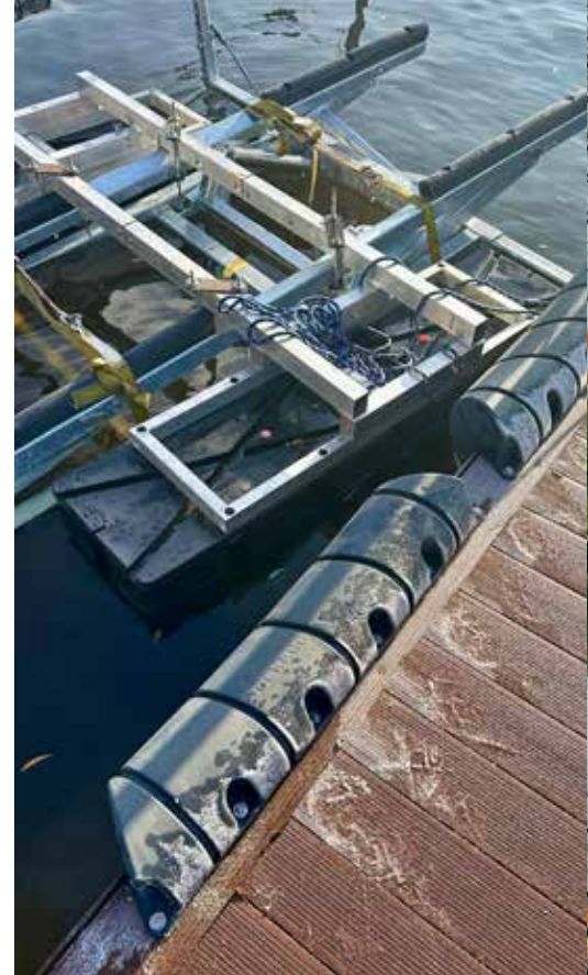
Montage mit Schwimmponton.
