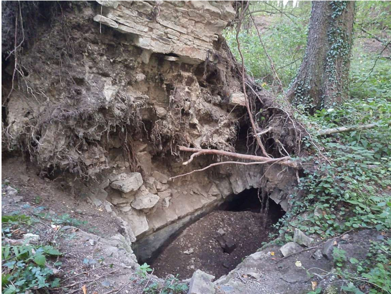
Kellergewölbe unter einem umgestürzten Baum auf einer Wüstungsfläche
