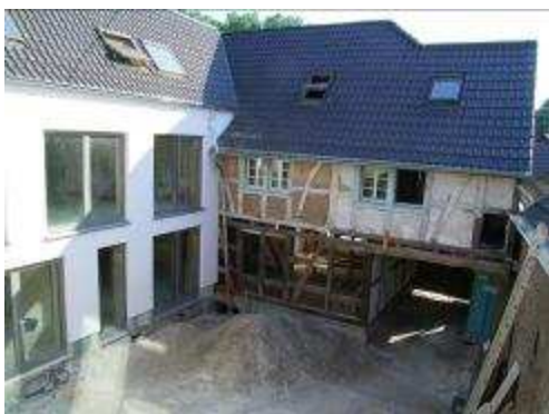
Der Hofbereich in der Renovierungsphase
