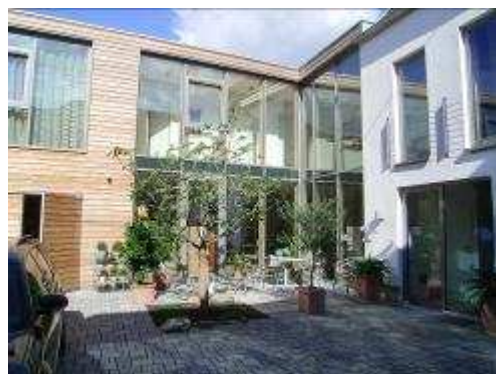
Der fertiggestellte Innenhof
