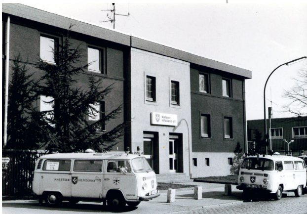
Der Malteser Standort an der Franziusstraße Anfang der 1980er Jahre
