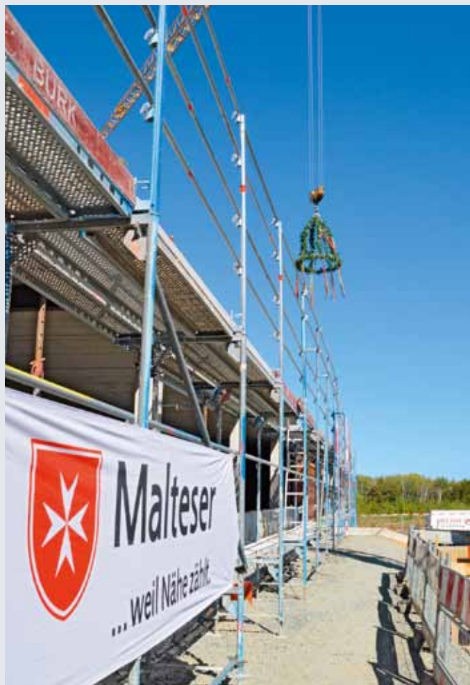
Die Richtfestkron weht über dem Rohbau des neuen Ausbildungszentrums der Malteser in Wetzlar.
