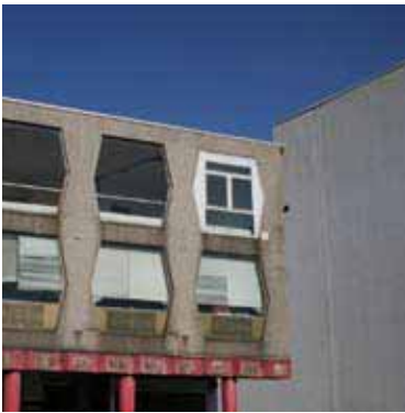
Bebauung an der Gohrmühle
