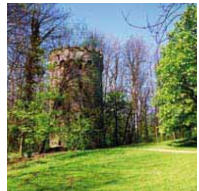
Wasserturm auf dem Quirlsberg
