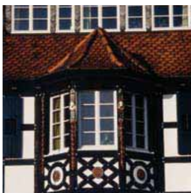
Element der Fassade des Rathauses
