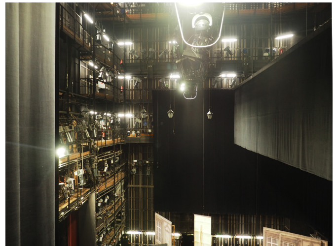
Abb. 210 Arbeitsgalerien im Bühnenturm des Opernhauses Chemnitz
