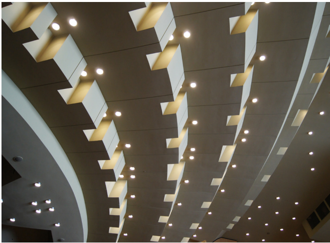
Abb. 238 Deckengestaltung des Zuschauersaals
