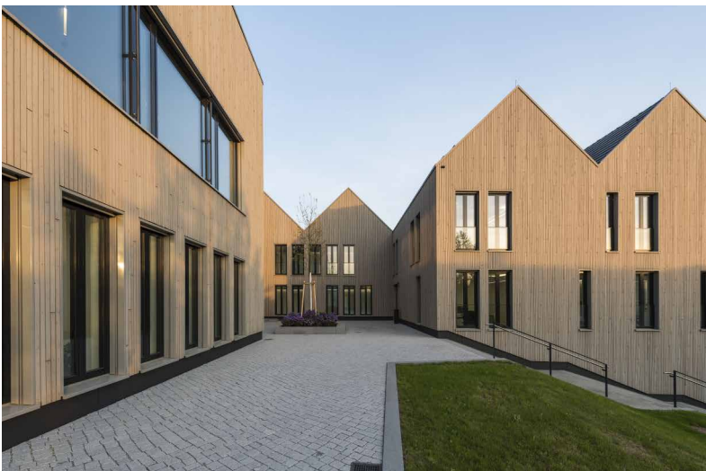
Neubau des Rathauses Walzbachtal-Wössingen
