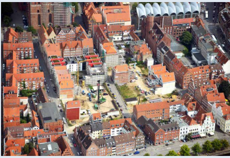
Vogelperspektive auf die Baustelle des Gründungsviertels in Lübeck
