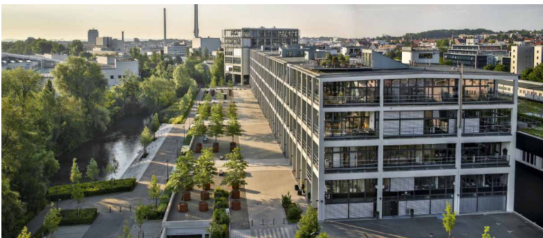
Stadregal Ulm – Beispiel für den ressourcenschonenden Umgang mit Bestandsstrukturen
