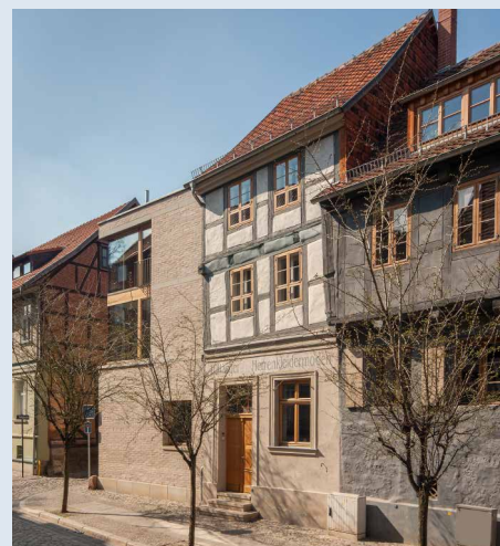
Das Gebäude in der Häuserreihe nach der denkmalgerechten Sanierung
