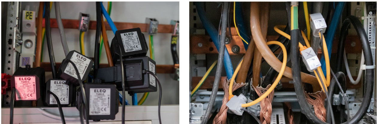
Abbildung 21: Anwendung von Klappstromwandlern und Rogowski-Spulen in der Praxis
