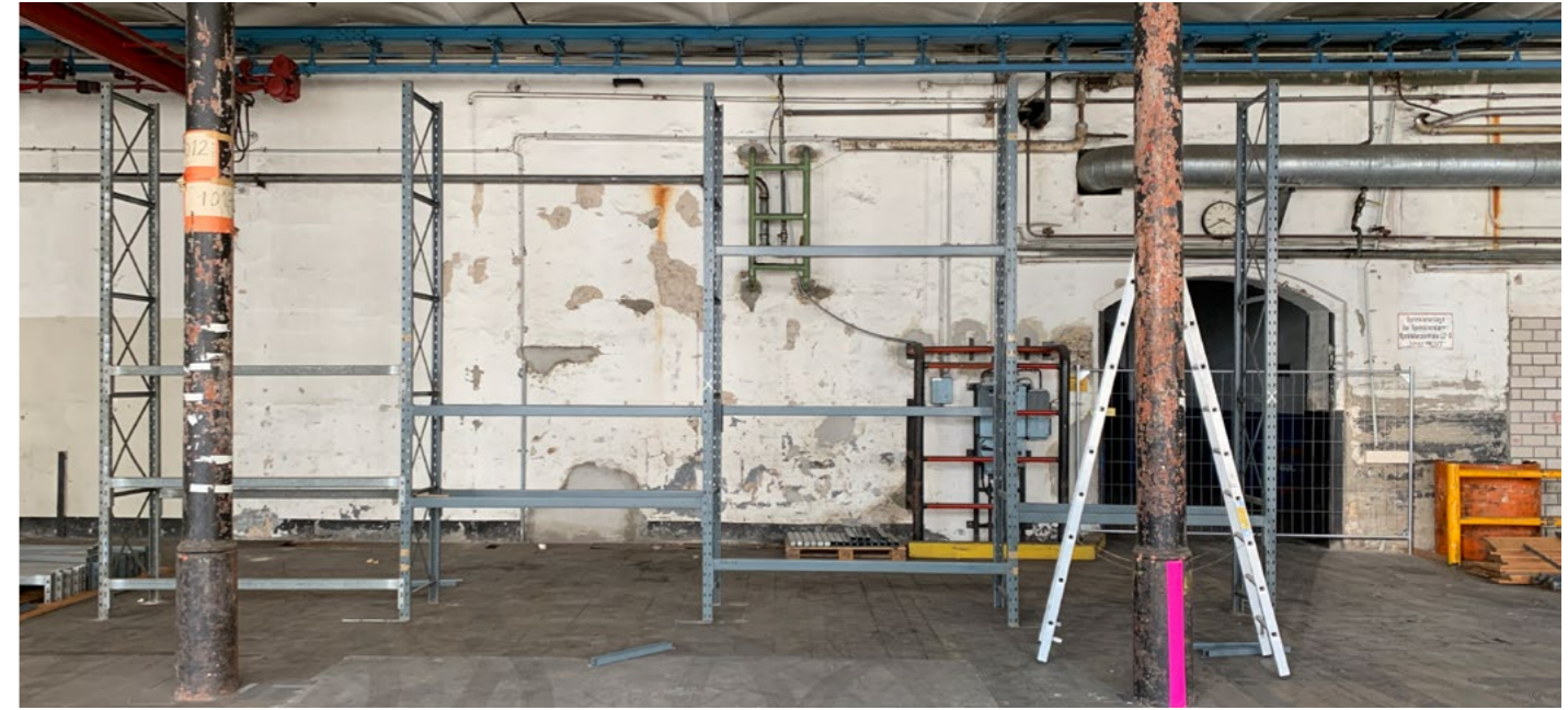
Aufbau Stahlregal im Erdgeschoss
