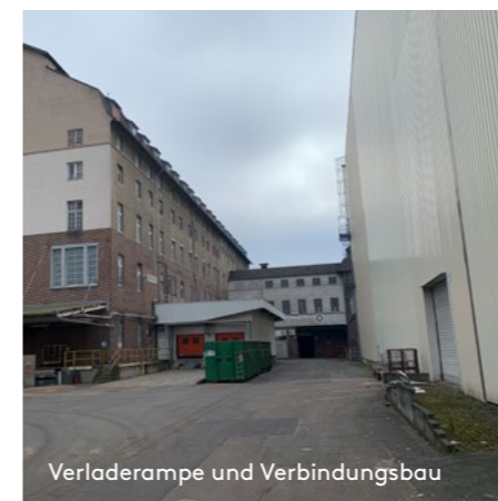
Blick von hinten links: Halle PM 3 rechts: Sortiersaalgebäude
