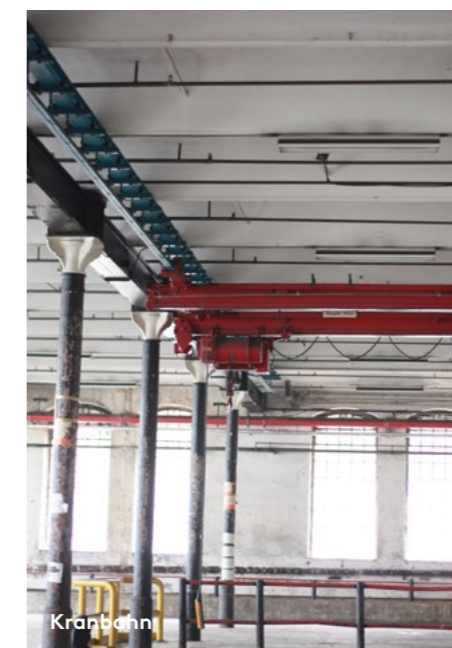
Stützenkopf mit Auflager der Längsträger
