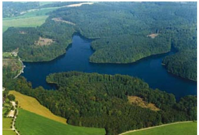
Die Wupper–Talsperre ist eine Brauchwasser–Talsperre und der jüngste Stausee im Wasserquintett. Sie dient der Niedrigwasseraufhöhung, dem Hochwasserschutz der Wupper und der Wasserkrafterzeugung. Der Bau des ca. 40 m hohen Hauptdammes erfolgte von 1982 bis 1987.
