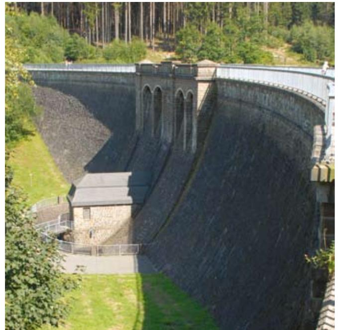
Die Brucher–Talsperre gehört zur Gemeinde Marienheide und dient neben der Hochwasserregulierung der Niedrigwasseraufhöhung und der Naherholung. Die 27,5 m hohe Staumauer – 1913 nach dem Intze–Prinzip gebaut – wurde in den 1990er Jahren saniert und verstärkt. Die Talsperre ist hauptsächlich von Wäldern umgeben. Der Stausee dient intensiver Freizeitnutzung wie Camping, Segeln, Surfen, Bootfahren und Angeln.
