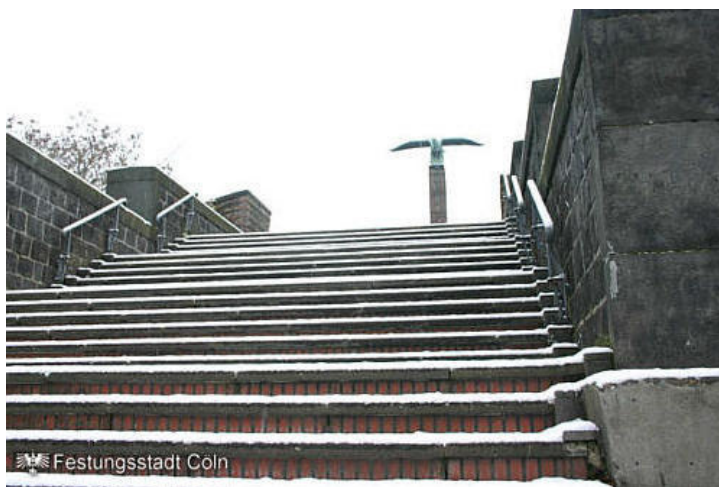
Abb. 24. Diese Treppe ist als Hintergrund auf der Zeitungsabbildung zu sehen (s.o.) und führt zum Adlerdenkmal hoch. Abbildung mit Genehmigung vom Betreiber der Internetseite https://koelner-festungsbauten.de .
