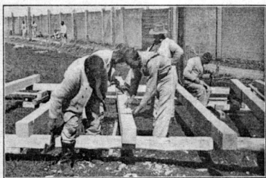
Handwerker bei der Arbeit
