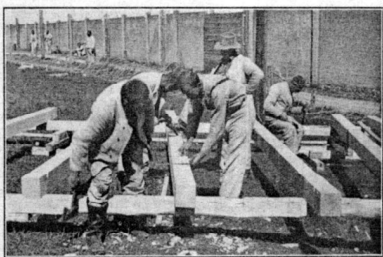
Handwerker bei der Arbeit
