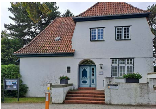
Vorwerker Friedhof: Verwaltungsgebäude
