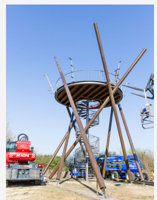
Bauausführung Vogelnest Hochheim 2020 Foto: Sabine Klein
