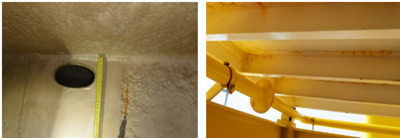
Abb. 1: Beschichtungsschäden und Korrosion an lokal beanspruchten Konstruktionselementen in Ballasttanks, links, und an einer Offshore-Struktur, rechts (Copyright: Muehlhan AG, Hamburg)
