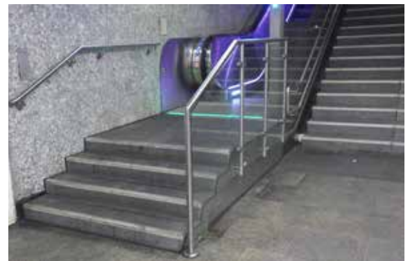
Neue Treppe an der Haltestelle Appellhofplatz/Zeughaus
