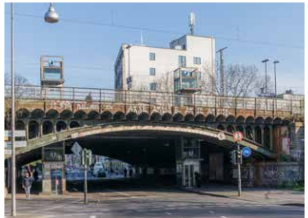
Eisenbahnbrücke über die Venloer Straße
