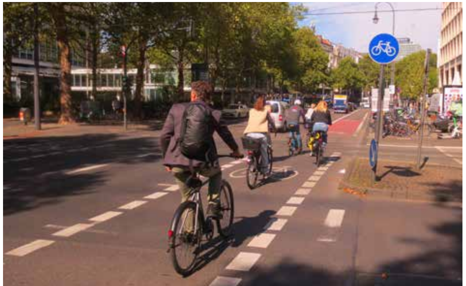
Das Projekt „RingFrei“ zeigt, dass gute Infrastruktur eine wesentliche Voraussetzung für die Zunahme des Radverkehrs ist. Es zeigt auch, dass Radfahren auch ohne bauliche Trennung sicher sein kann, wenn die Radspuren hinreichend breit und die Fahrgeschwindigkeiten abgesenkt sind.
