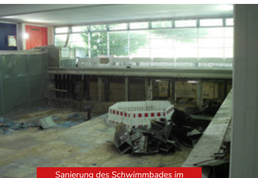
Sanierung des Schwimmbades im Sportpark Nord in 2014
