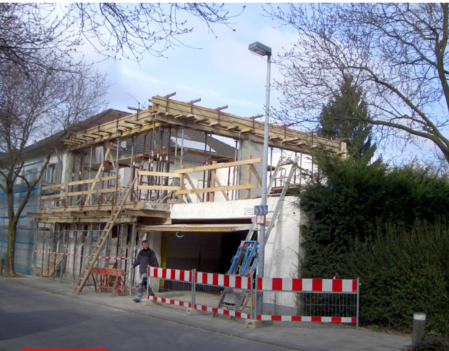
Umbau des Bootshauses in 2006
