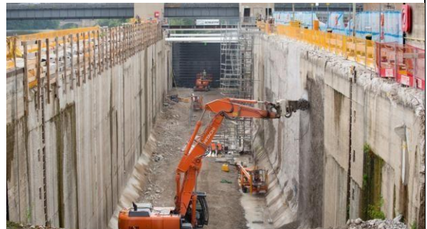
Grundinstandsetzung linke Schleusenammer Lauffen (WNA Heidelberg)
