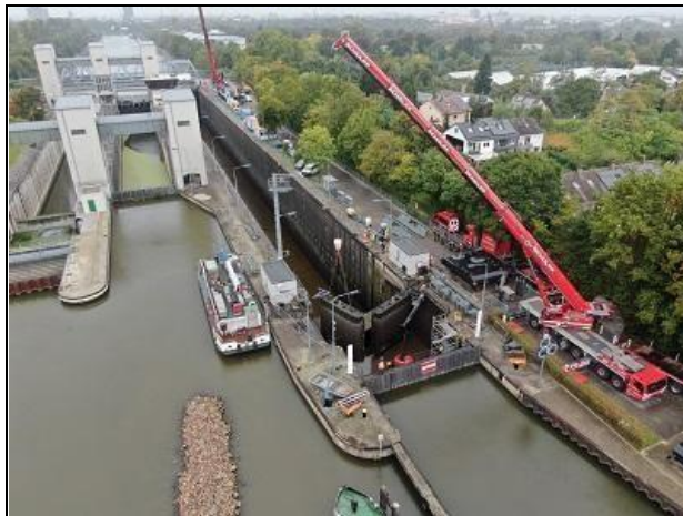
Tausch der Tore der Schleuse Feudenheim 2025 (WSA Neckar)
