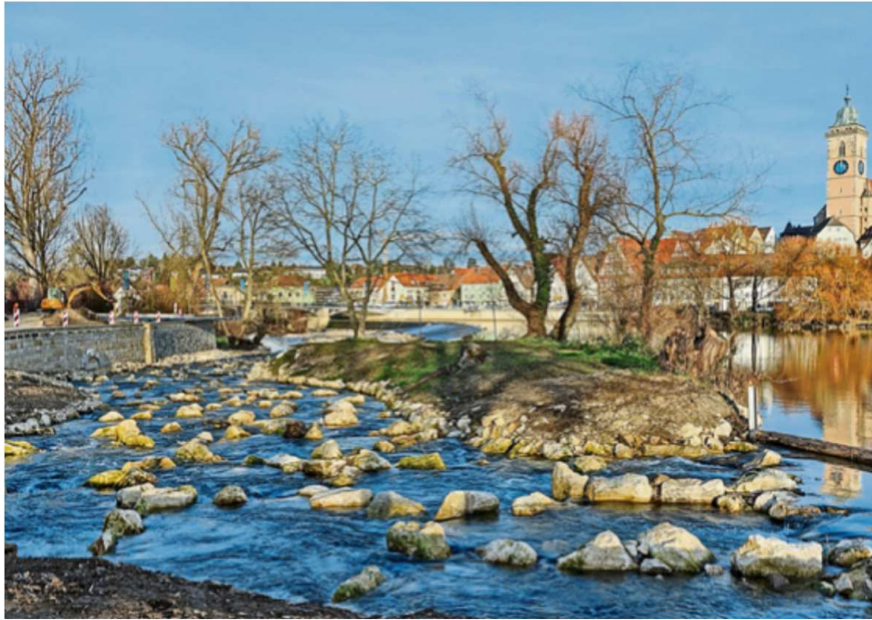
Die Fischtreppe in Nürtingen, erbaut 2013 neben dem alten Streichwehr gegenüber der malerischen Altstadt (Foto: Holzwarth/Nürtinger Zeitung v.12.12.2013)
