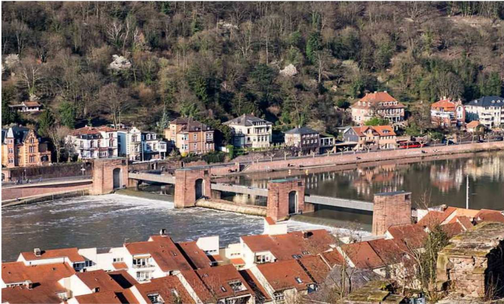
Als Beispiel das Wehr der Neckar-Staustufe Heidelberg vom Schloß aus gesehen - (erbaut 1927 -29) die Doppelschleuse liegt rechts außerhalb des Fotos (Foto: © Alexander Hoernigk (via Wikimedia Commons))
