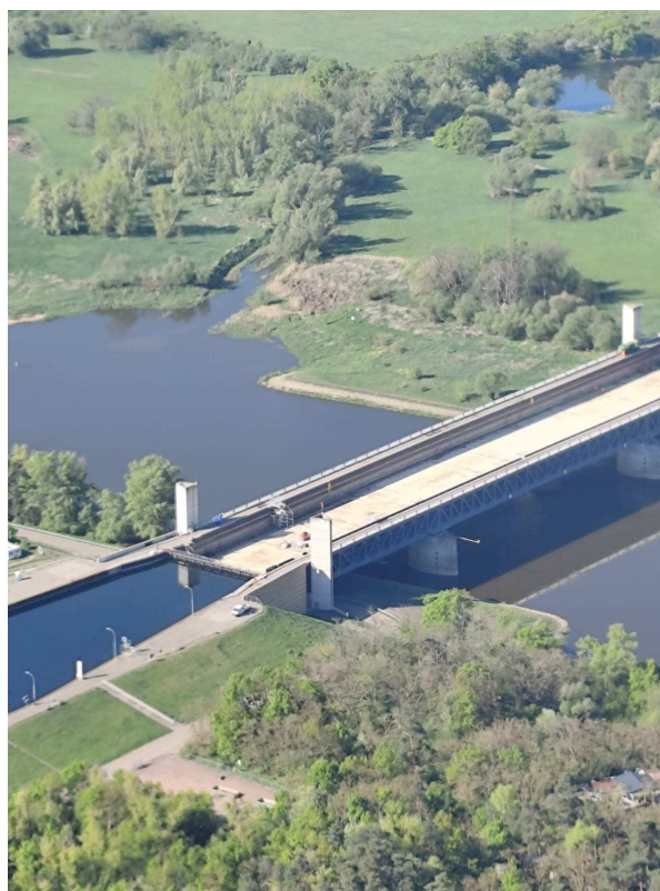
Und hier die Strombrücke über die Elbe (228 m) ab dem Ostufer bei Hohenwarthe (Fotos: Bärbel Böttger)
