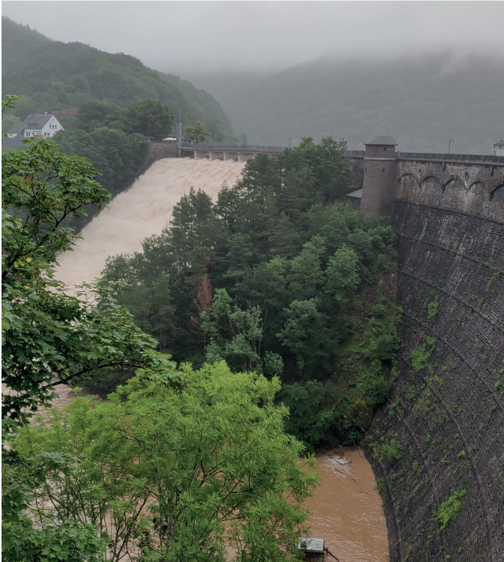
Bild 2: Hochwasserentlastungsanlage der Urfttalsperre in Betrieb während des Hochwassers von Mitte Juli 2021. Foto: Maximilian Born (2021)
