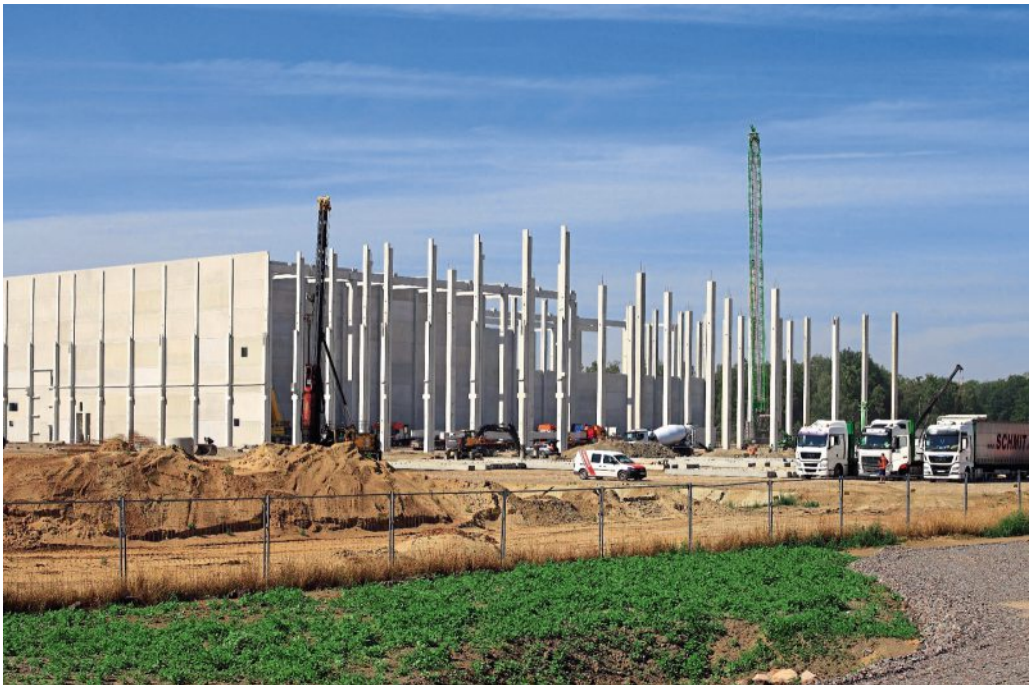
Abb. 40: Entstehung eines neuen Gewerbegebietes (NW: RE) (GU: 8.1.1). (Foto: F. Helbing)
