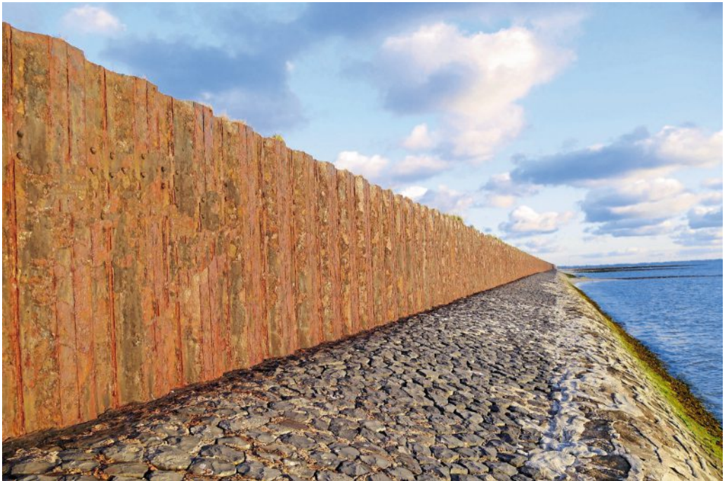
Abb. 25: Durch Buhnen und Spundwand festgelegter Küstenabschnitt auf Spiekeroog (NI: WTM) (GU: 4.2.1). (Foto: S. Kämpfer)
