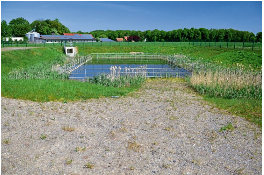
Abb. 27: Regenrückhaltebecken können bei richtiger Anlage eine große Bedeutung für den Artenschutz erlangen. Bei Trockenbecken mit flachen Böschungen und Temporärgewässern – wie im oberen Bild dargestellt – ist dies der Fall (NW: MS). Für relativ naturferne Dauerstaubecken mit steilen Böschungen gilt dies nur in Grenzen (unten) (NW: WAF) (GU: 5.2.2). (Foto: T. Fartmann)
