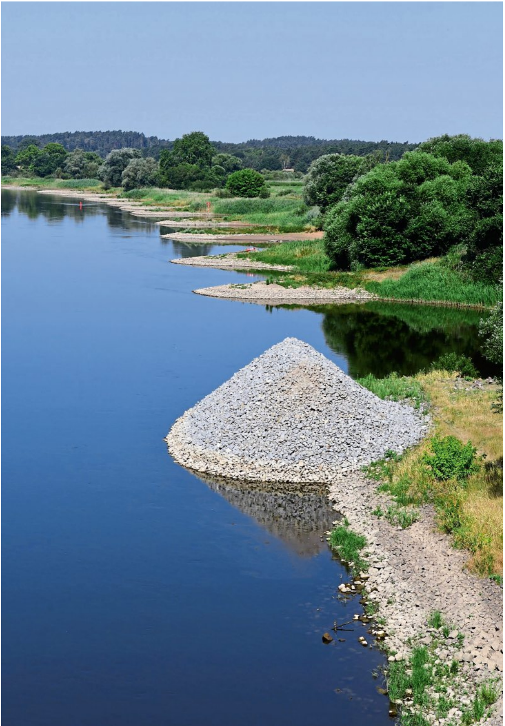
Abb. 31: Uferverbau durch Steinschüttungen und Buhnen an der Elbe (MV: LUP) (GU: 5.3.4). (Foto: T. Fartmann)
