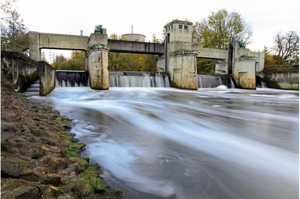
Abb. 33: Staustufe an der Lippe (NW: UN) (GU: 5.3.6). (Foto: O. Niepagenkemper)
