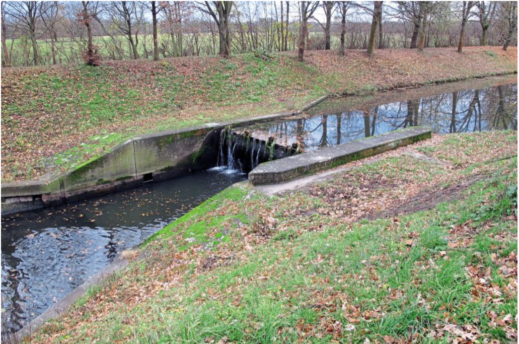
Abb. 34: Technisch ausgebautes Gewässer mit Querbauwerk (NW: COE) (GU: 5.3.6). (Foto: O. Niepagenkemper)
