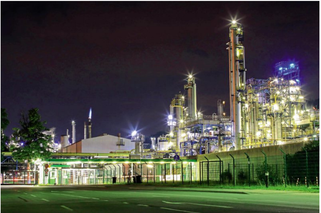
Abb. 65: Lichtverschmutzung durch eine Raffinerie (NW: RE) (GU: 16.2.1). (Foto: F. Helbing)
