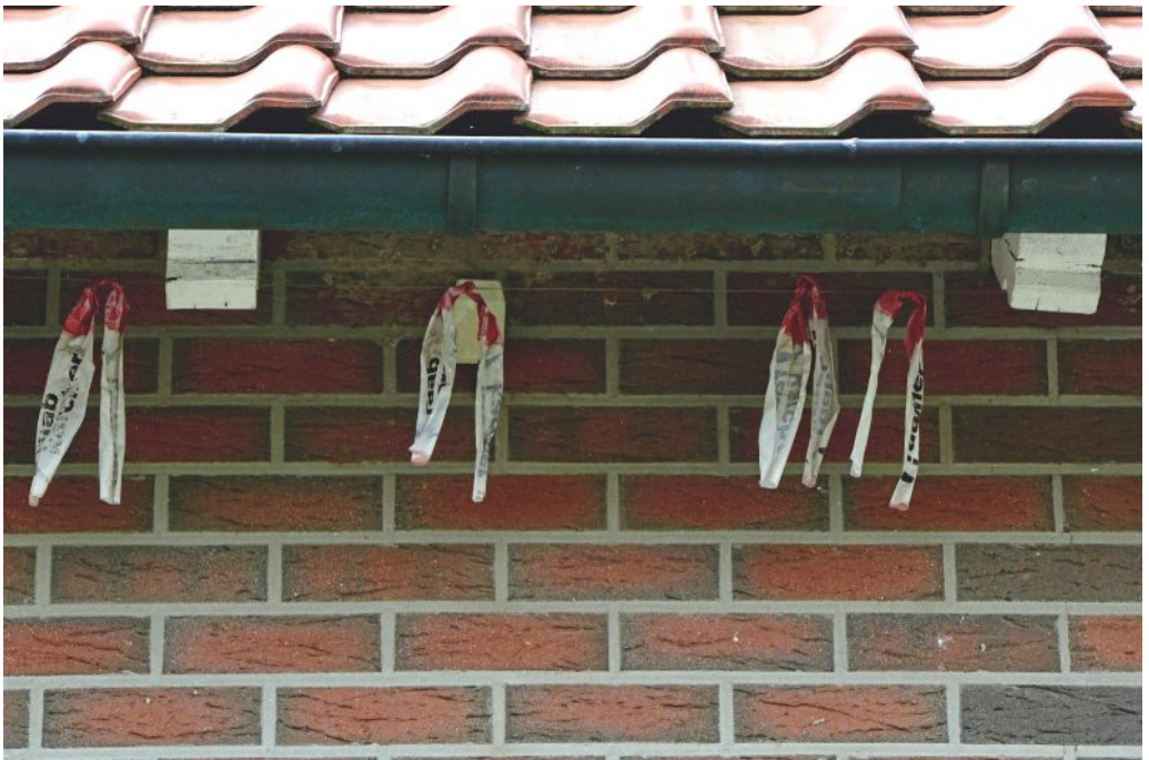
Abb. 44: Vergrämung von Mehlschwalben ( Delichon urbica ) an einem Neubau mittels Flatterband (BB: UM) (GU: 8.3.1). (Foto: T. Fartmann)
