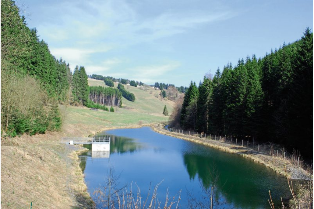
Abb. 54: Durch den Bau eines Speicherbeckens zur Produktion von Kunstschnee überformtes Bachtal (NW: HSK) (GU: 12.1.3). (Foto: T. Fartmann)
