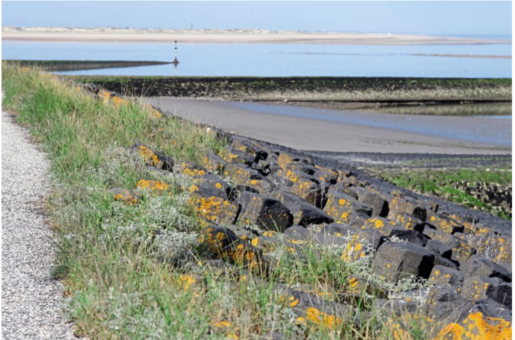
Abb. 24: Durch Buhnen und ein Schrägbauwerk befestigter Inselabschnitt auf Baltrum (NI: AUR) (GU: 4.2.1). (Foto: F. Löffler)
