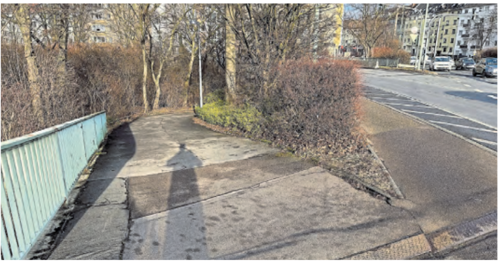
Das Drängelgitter auf der steilen Abfahrt ist von der Severinsbrücke aus nicht erkennbar.
