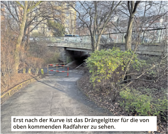
Das Drängelgitter auf der steilen Abfahrt ist von der Severinsbrücke aus nicht erkennbar.
